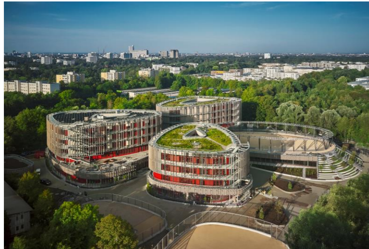
Gymnasium Wilhelm Hausenstein Bogenhausen . Klimapark
